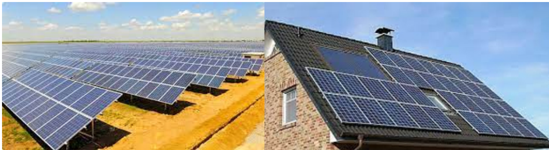
Рис. 3.1: Варіанти встановлення сонячних панелей
