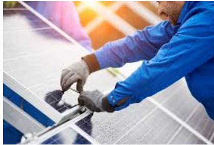
Рис. 3.3: Встановлення сонячної панелі
